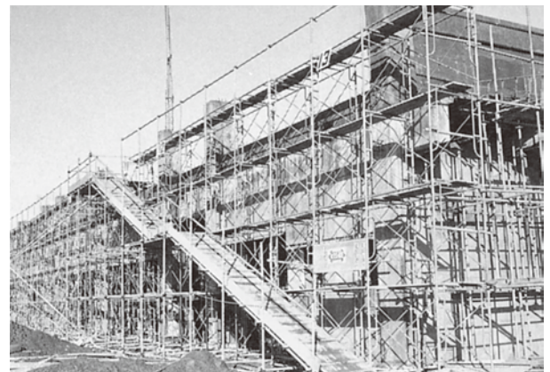
卸売棟建築工事(昭和47年)
