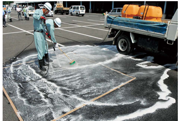
場内除染作業
