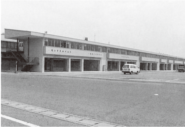
青果仲卸棟増築工事完成
