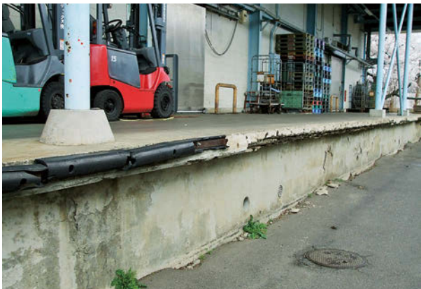
場内老朽化施設箇所
