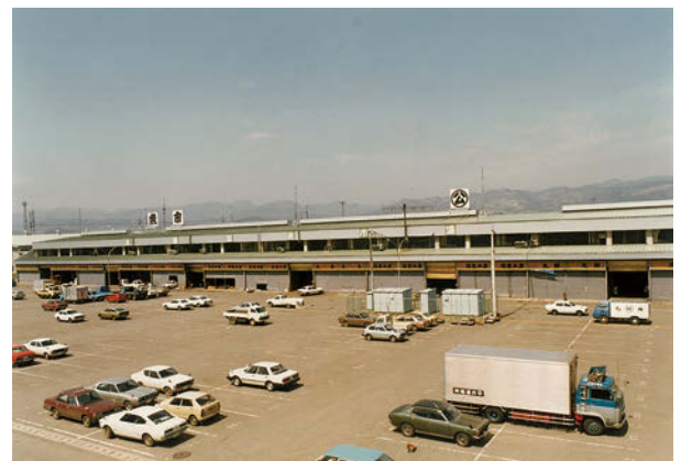
水産棟屋根・トップライト工事
